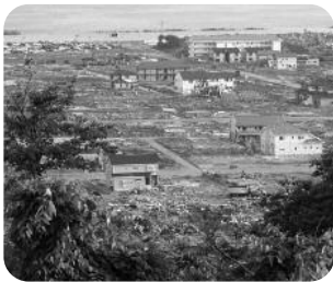
根こそぎさらわれた石巻の街
